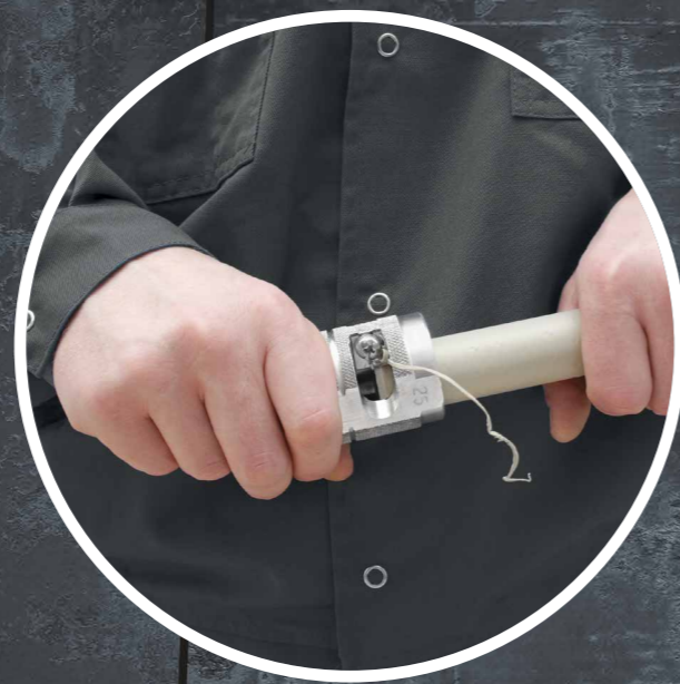
02 Удаление слоя алюминия инструментом для зачистки труб (касается труб stabiAL PPR).
