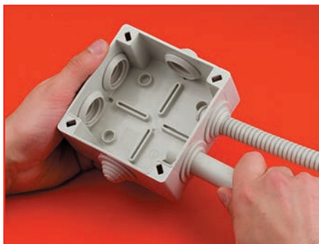
2 этап. Ввести гофрированную и жесткую трубы
