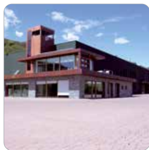
NEW PRODUCTION UNIT San Maurizio d'Opaglio (NO)
